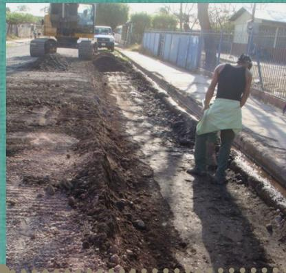
este mes de febrero y de manera intermitente, se laboró en las actividades de gaveteo y colocación de sub-base y base granulares. Con la maquinaria municipal y maquinaria de acarreo alquilada, se removió una capa de 50 centímetros y se colocaron capas de material granular.
