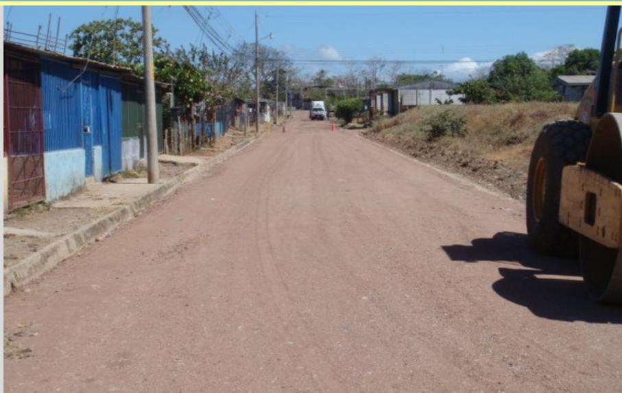
laboró en la conformación y bacheo mecanizado colocándose 90 metros cúbicos de material lastre e invirtiéndose alrededor de 20 horas de maquinaria (niveladora, compactadora, cargador).
