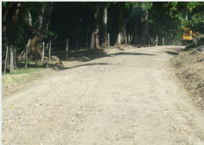
Se realizaron las actividades de conformación y bacheo mecanizado de las secciones más deterioradas del camino. Se colocaron 150 metros cúbicos de material y se invirtieron alrededor de 100 horas de maquinaria.
