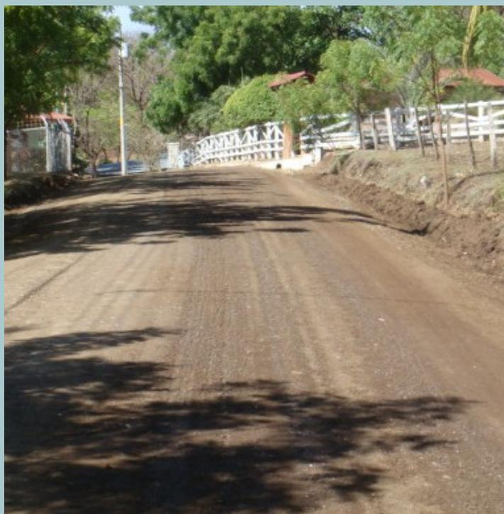
Con maquinaria alquilada y una vagoneta municipal, se realizaron las actividades de cuneteado, conformación y bacheo mecanizado de la superficie de ruedo, en el tramo de 2.6 kilómetros, comprendido entre las estaciones 1+200 y 3+800.
