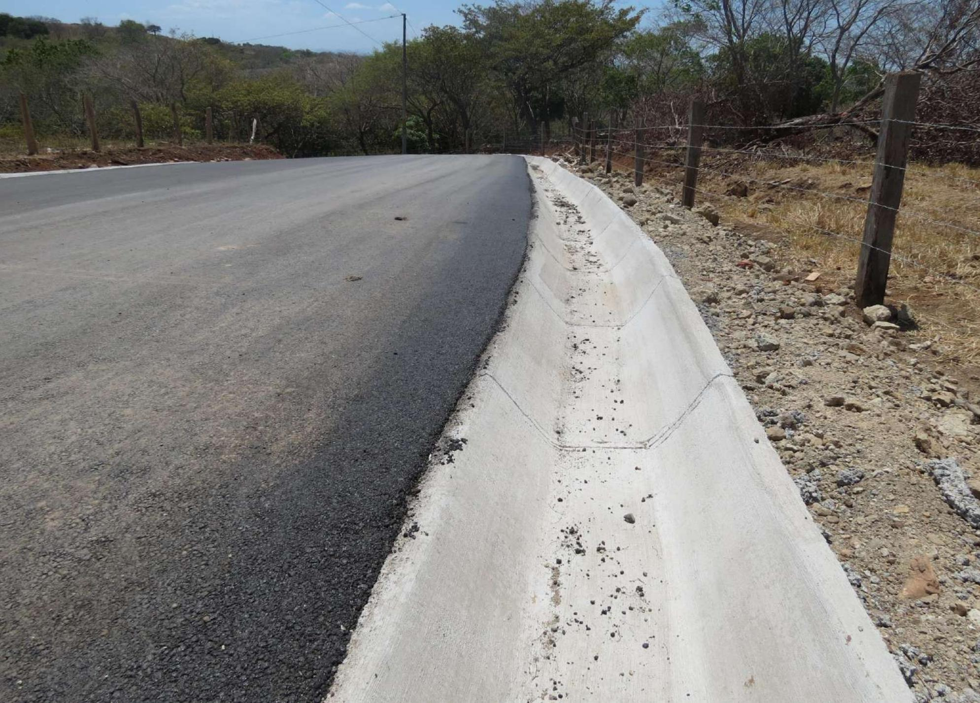
Distrito San Miguel (Higuerón), construcción de cuneta + recuperación derechos de vía, mejoramiento de superficie de rodamiento en tramo con pendiente pronunciada.
